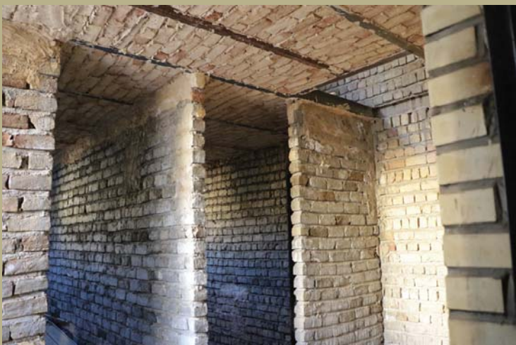
اتاق کنترل؛ در حال ساخت
